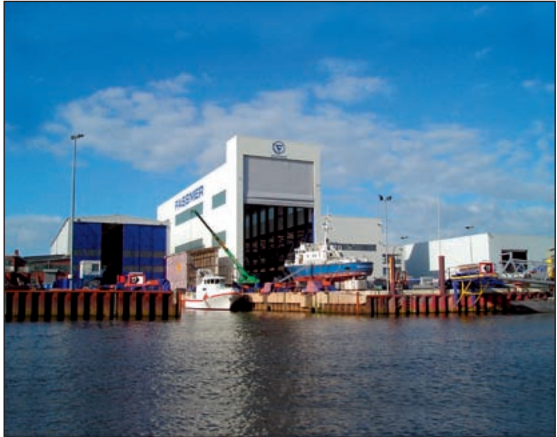
Das Betriebsgelände der Fr. Fassmer GmbH & Co. KG in Berne-Motzen am Westufer der Unterweser.
